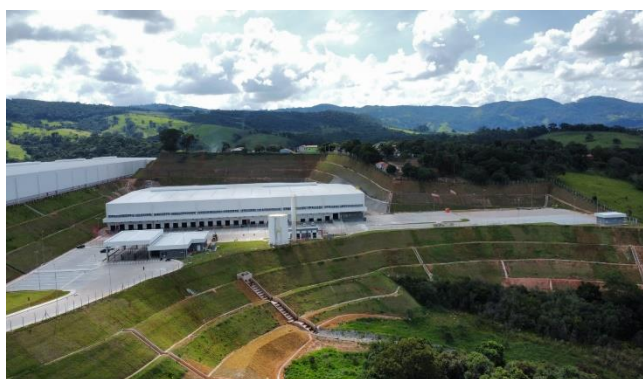
Execução de obras – Foto Panorâmica
