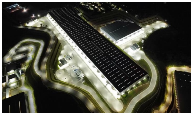
Execução de obras – Foto Panorâmica
