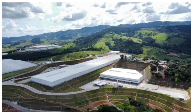
Execução de obras – Foto Panorâmica
