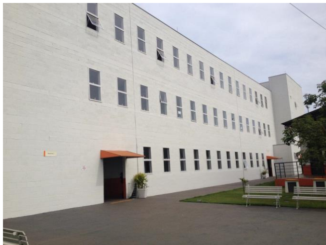
Bloco C – Fachada
