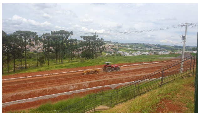
Fotos da via em obra.
