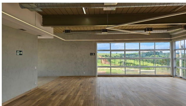
Foto obra restaurante Citlog Sul de Minas.
