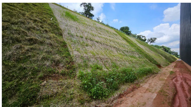
Foto de recuperação talude.
