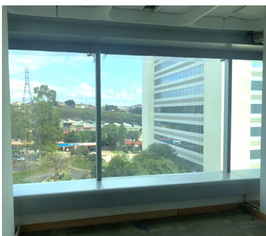
Vista Externa – Andar Tipo
