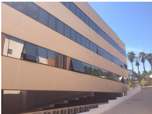
Bloco Administrativo 02 – Fachada Lateral
