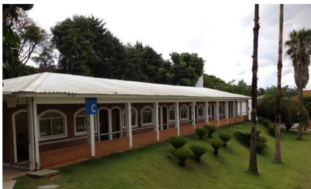
Fachada – Bloco C
