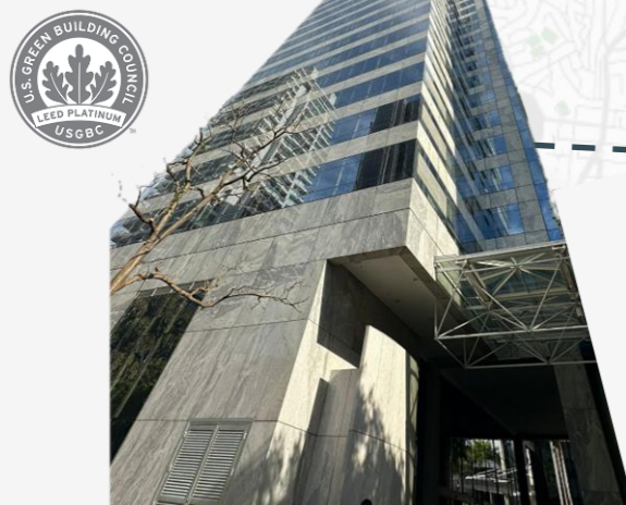
Edifício Torre Sul
