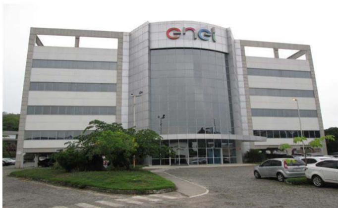
Ampla - São Gonçalo, RJ
