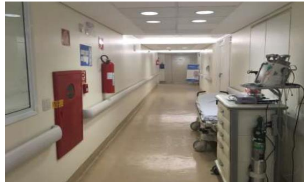
Área interna do Hospital
