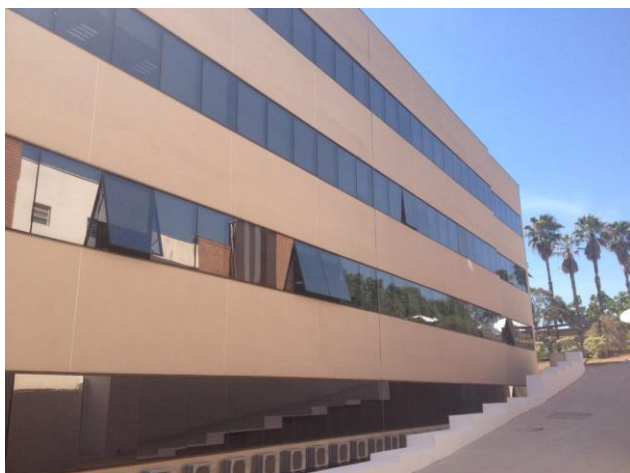
Bloco Administrativo 02 – fachada lateral
