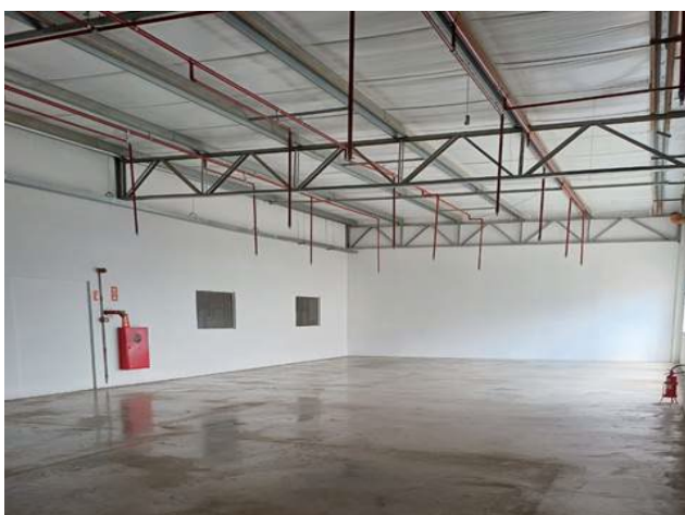
Pintura paredes do mezanino.
