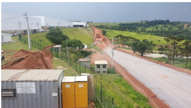
Fotos da via em obra.
