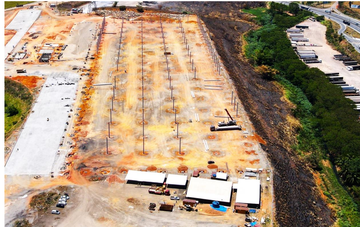
Sapatas de fundação do Galpão A finalizadas.
