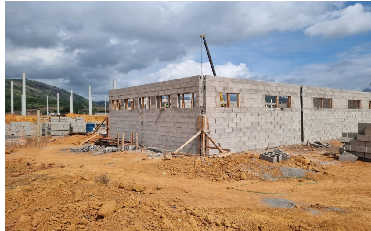
Execução de alvenaria de vedação do vestiário.
