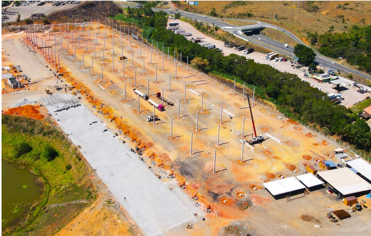
Sapatas de fundação do Galpão A finalizadas.
