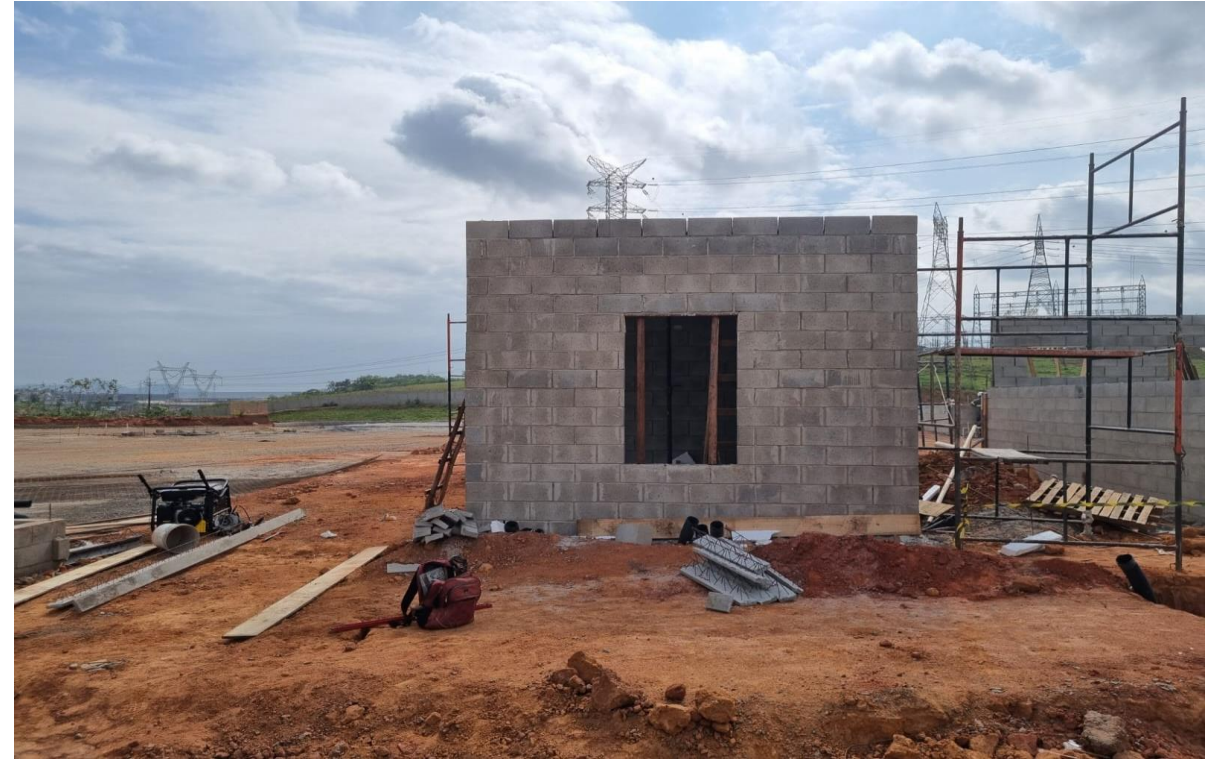
Execução da alvenaria e da laje pré-fabricada da sala do transformador.
