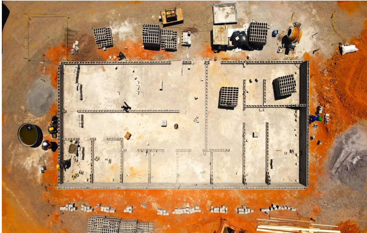
Execução de alvenaria para vedação da portaria.
