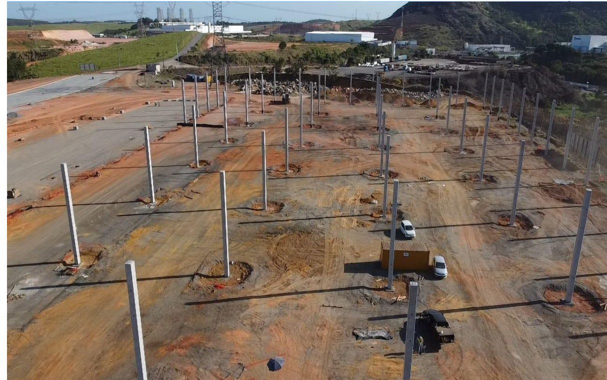
Íçamento dos pilares do Galpão A.
