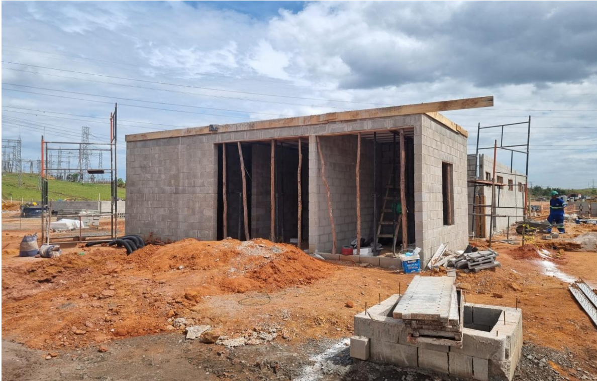
Execução da alvenaria e da laje pré-fabricada da sala do transformador.
