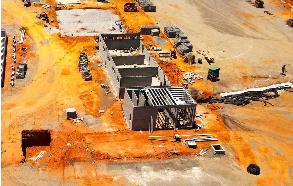
Execução de alvenaria de vedação do vestiário.
