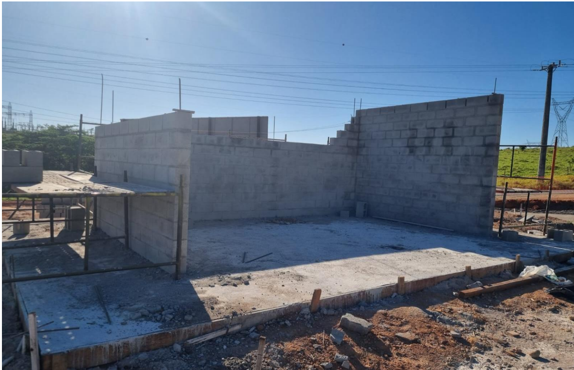
Execução de alvenaria de vedação da ARS.
