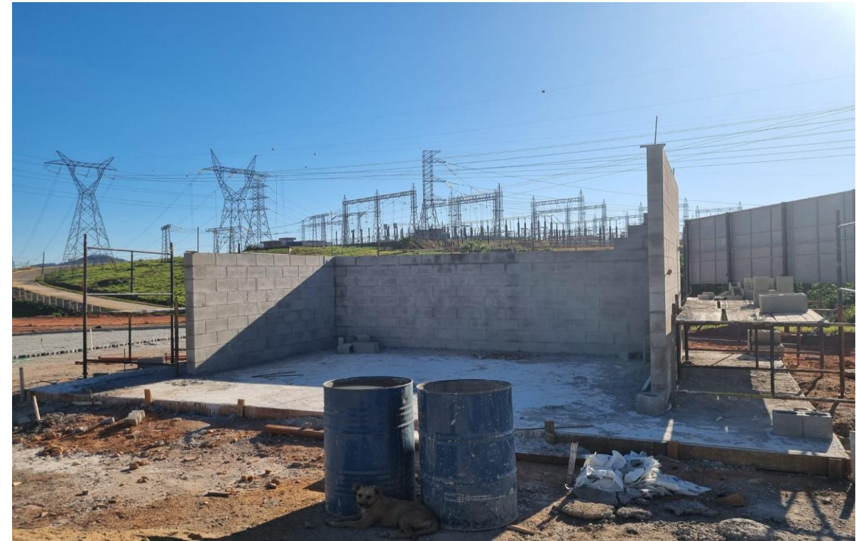
Execução de alvenaria de vedação da ARS.
