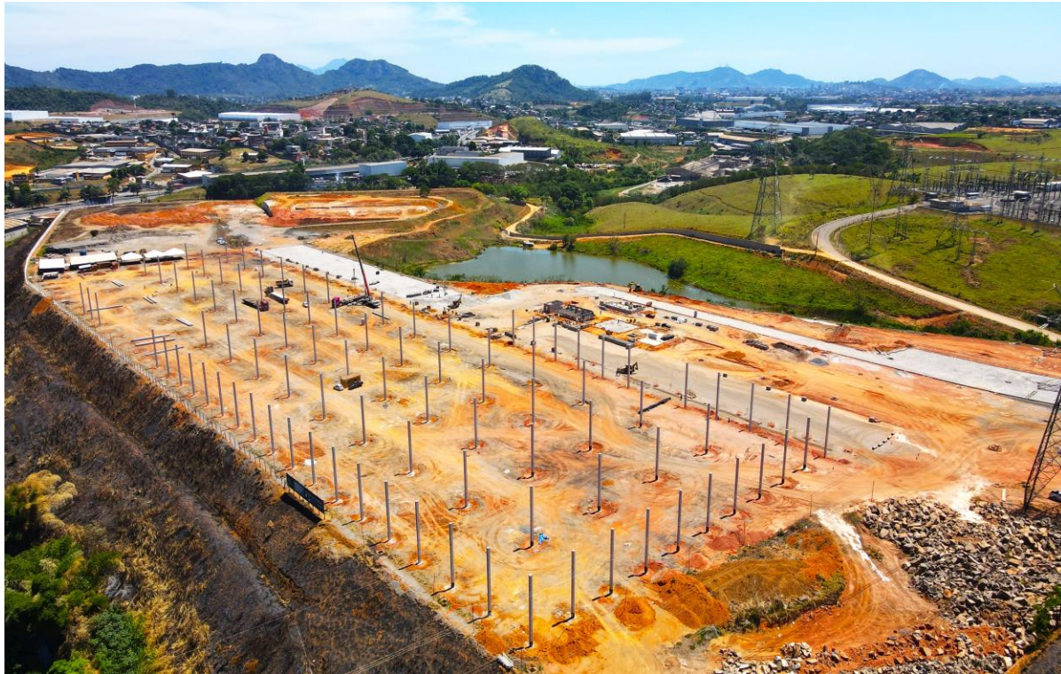
Íçamento dos pilares do Galpão A.
