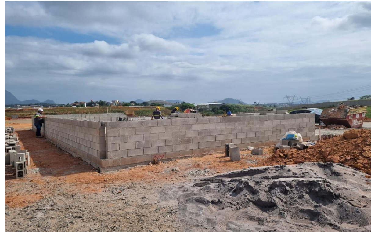
Execução de alvenaria para vedação da portaria.
