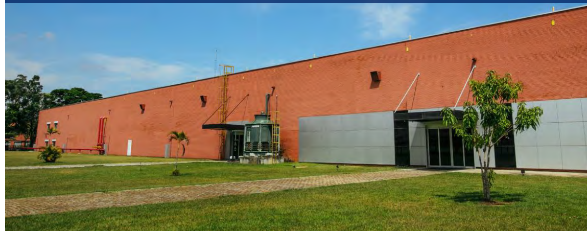
Galpão – área externa
