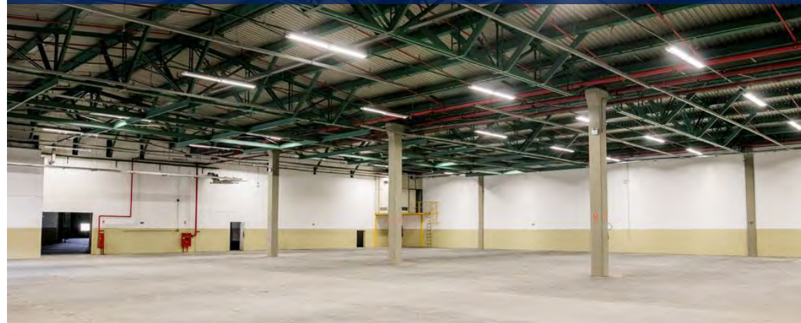
Galpão – área interna
