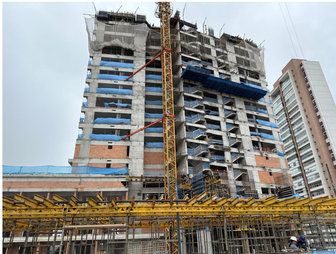
Foto da obra.
