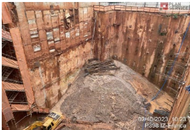
Vista Geral 3 (Vizinho Fundos x Av. 9 de Julho). Fonte: Planservice.
