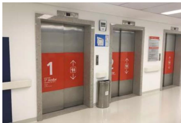
Hall dos Elevadores
