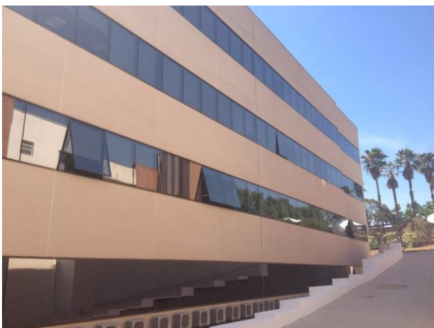
Bloco Administrativo 02 – fachada lateral
