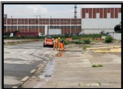
Limpeza das rede de drenagem
