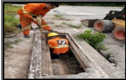
Limpeza da rede de drenagem
