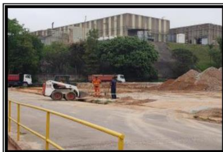
Limpeza das rede de drenagem
