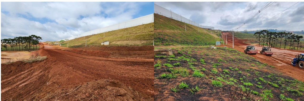
Fotos da via em obra.
