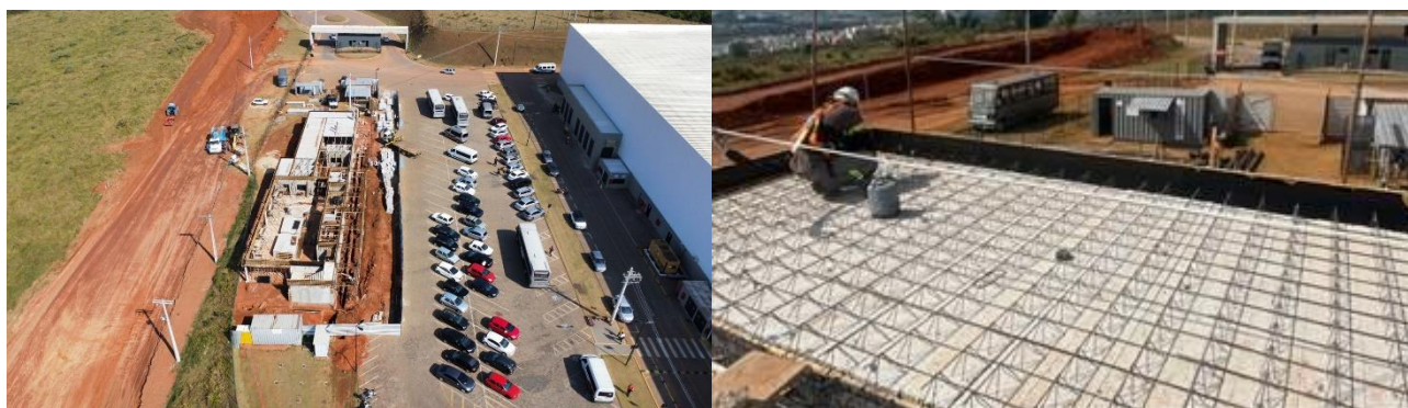
Foto obra restaurante Citlog Sul de Minas.
