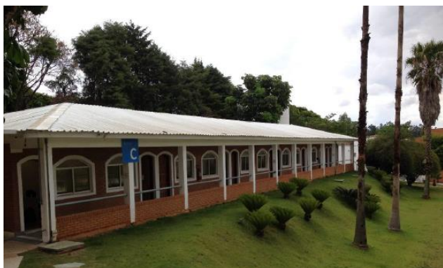
Fachada – Bloco C
