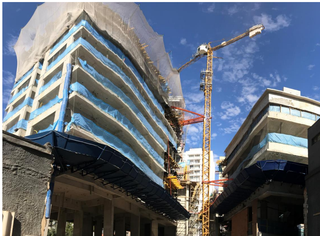
Foto da obra.
