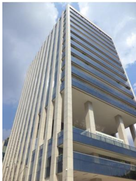
Fachada Traseira do Imóvel
