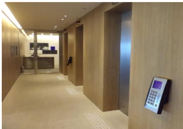
Hall dos Elevadores – Pavimento Tipo
