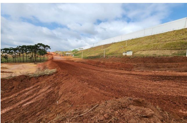
Fotos da via em obra.
