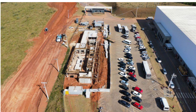
Foto obra restaurante Citlog Sul de Minas.
