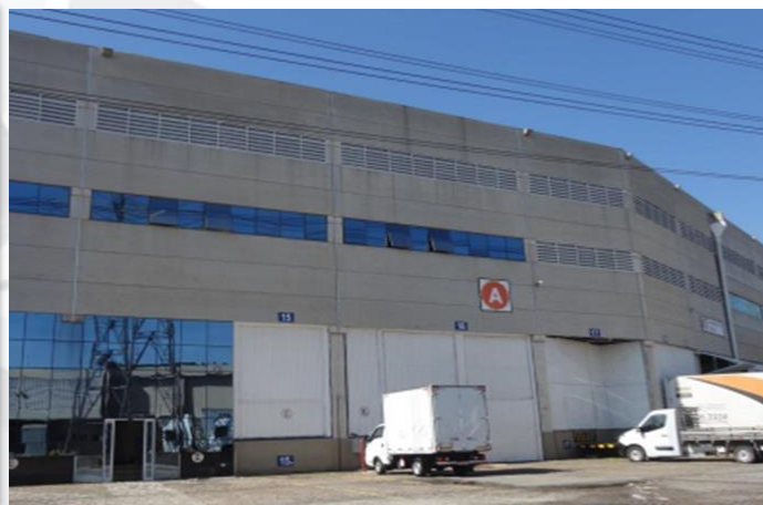
Foto do Galpão
