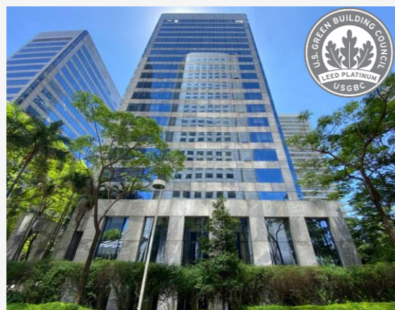
Ed. Torre Sul
