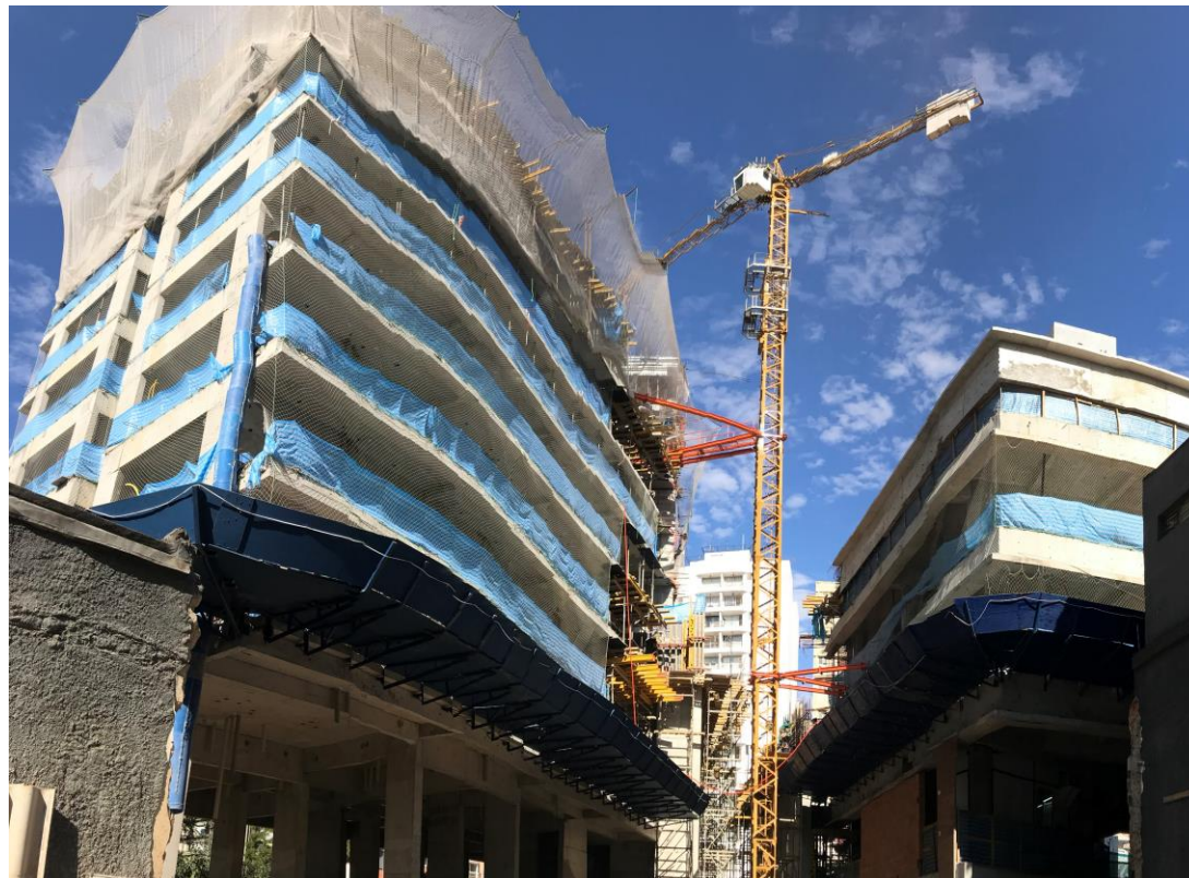
Foto da obra.
