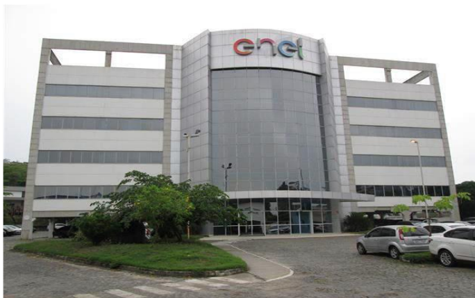
Ampla - São Gonçalo, RJ
