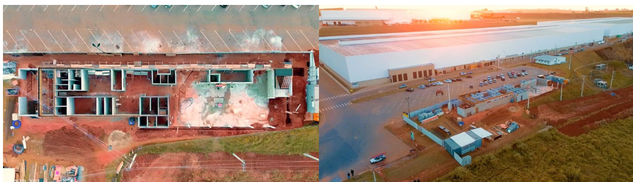
Foto obra restaurante Citlog Sul de Minas.
