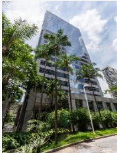
1. Ed. Torre Sul
