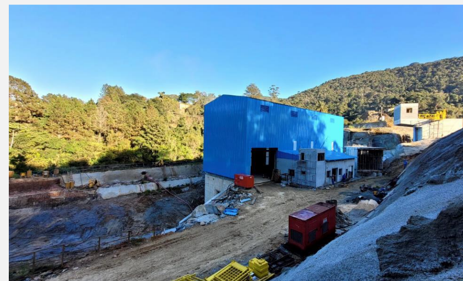
CGH Cascata em obras, previsão de conclusão para 2º semestre de 2023.
