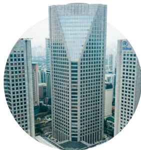
Ativo CENU Torre Oeste
