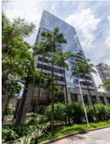
1. Ed. Torre Sul
