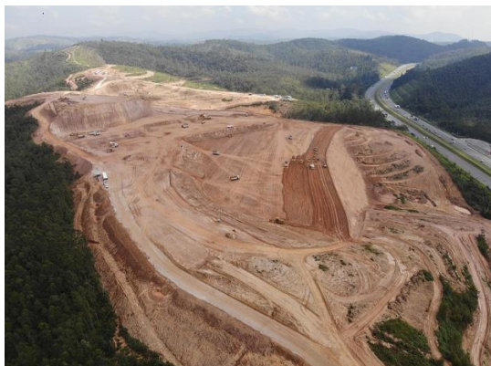
Execução de obras de terraplenagem
