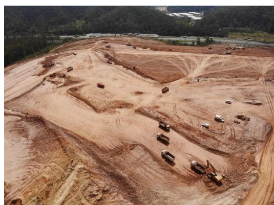
Execução de obras de terraplenagem
