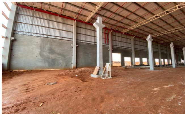
Montagem pilares pré-moldados do Mezanino do Módulo 13.
