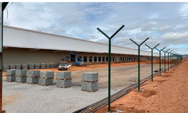
Pavimentação e gradil de fechamento perimetral do Eixo A.
