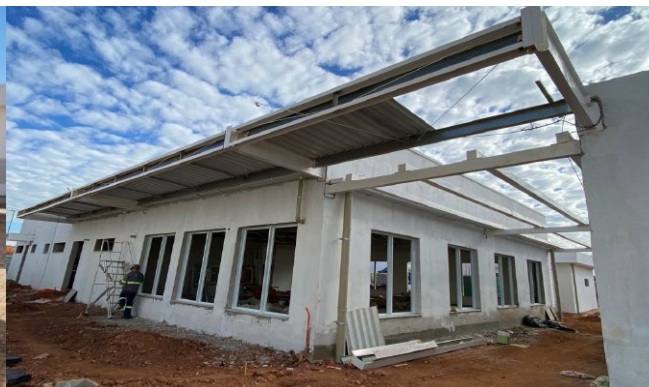
Cobertura, esquadrias e acabamentos do Restaurante.
