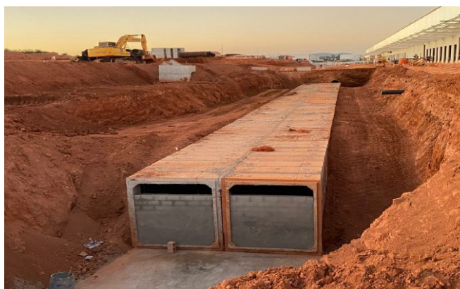
Reaterro do tanque de retardo da drenagem pluvial do Eixo A.
