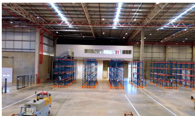
Mezanino e área de armazenagem e produção – BTS Marelli.
