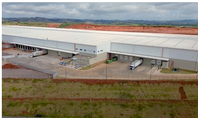
Fechamento perimetral, pavimento e docas dos Mód. 2 e 4 – BTS Marelli. Execução de Nichos de docas.
