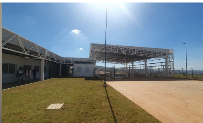
Portaria e eclusa – área interna.
