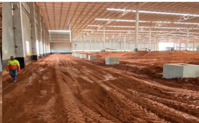
Execução dos blocos de fundação do mezanino do Módulo 12.
