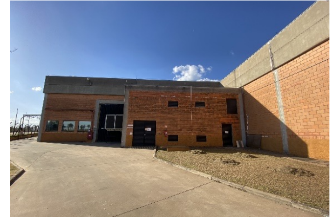
Fachada lateral do galpão
