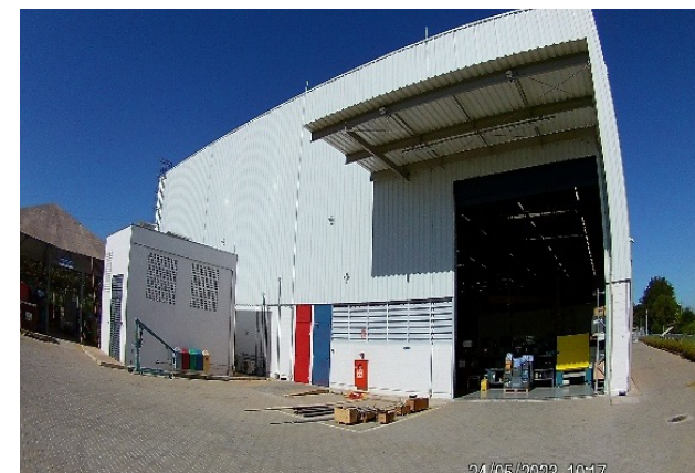
Fachada lateral do galpão
