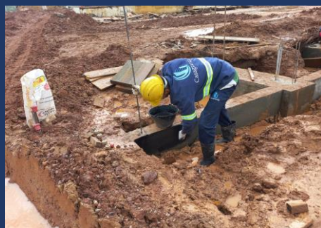
Impermeabilização das Vigas Baldrame
