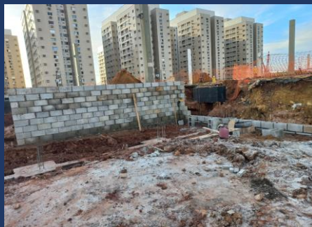
Execução Muro de Divisa
