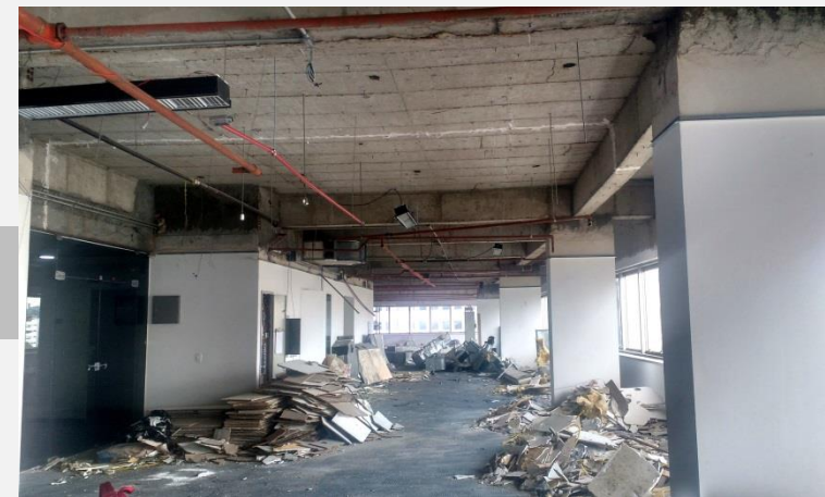
Obras em Andamento
