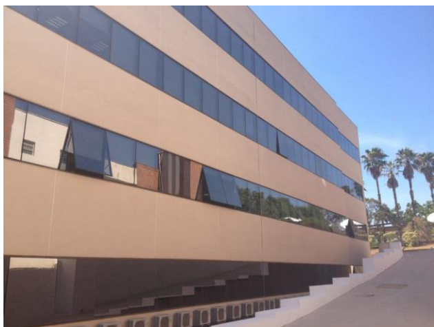
Bloco Administrativo 02 – fachada lateral
