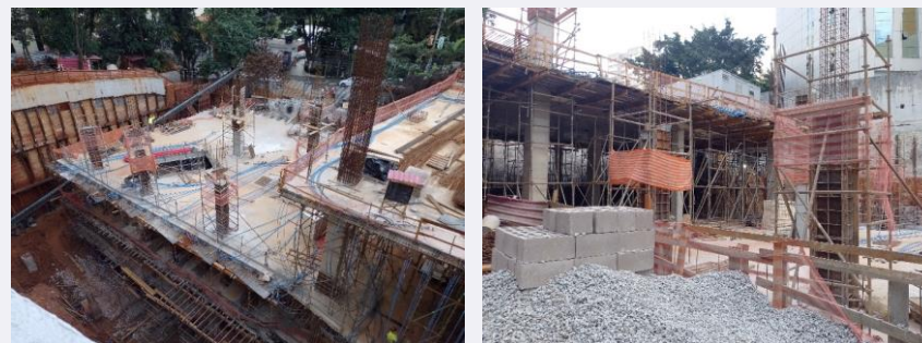
Fotos da obra no final de 2021
