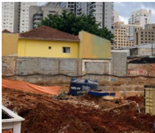
Vinci Moema – Escavação da Obra
