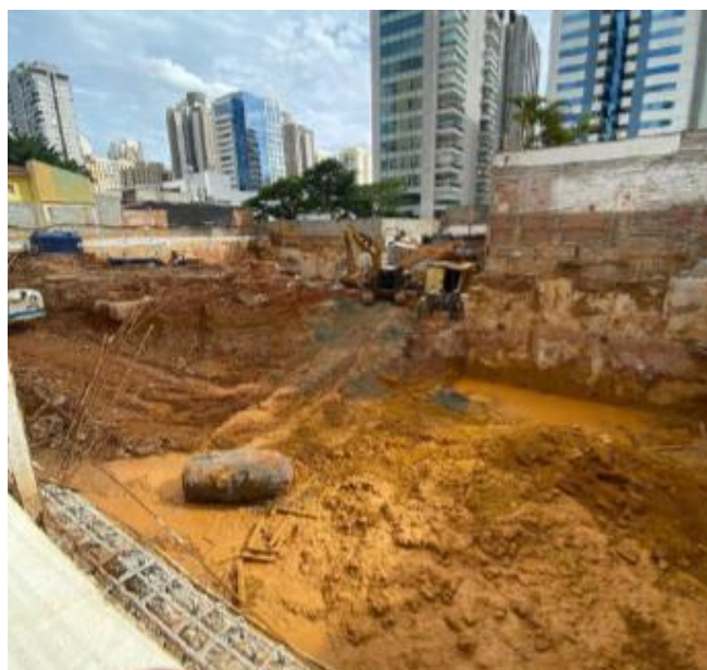
Vinci Moema – Escavação da Obra – Segundo nível
