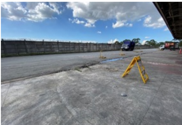
Manutenção corretiva da boca de lobo
