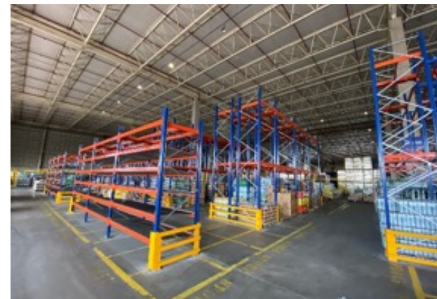
Vista interna do galpão
