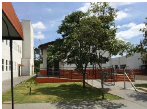
Vista Interna do Imóvel
