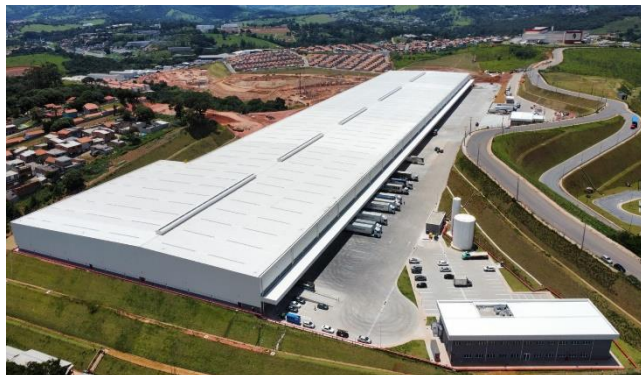
Execução de obras – Foto Panorâmica
