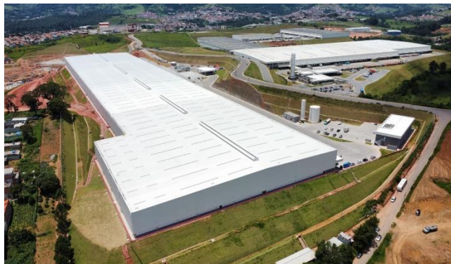
Execução de obras – Foto Panorâmica
