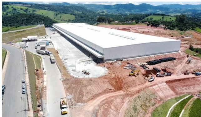
Execução de obras – Foto Panorâmica
