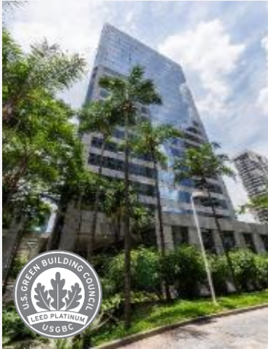
1. Ed. Torre Sul
