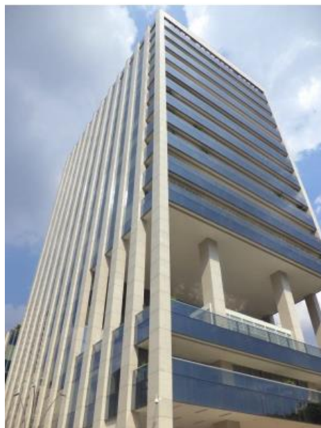
Fachada Traseira do Imóvel
