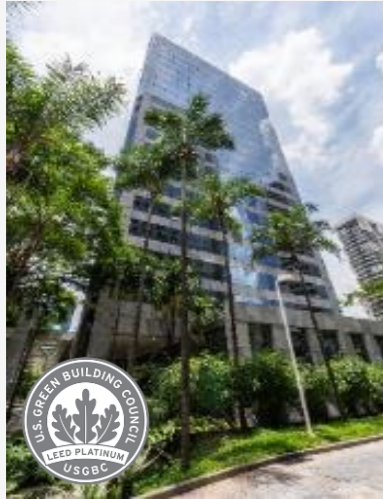
1. Ed. Torre Sul
