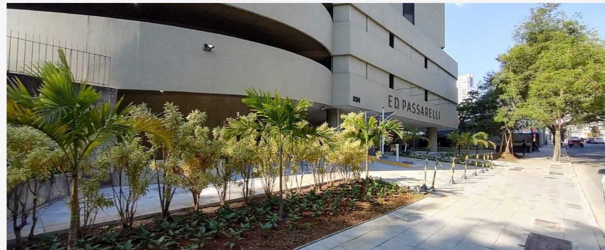
Ed. Passarelli – Rua Paes Leme
