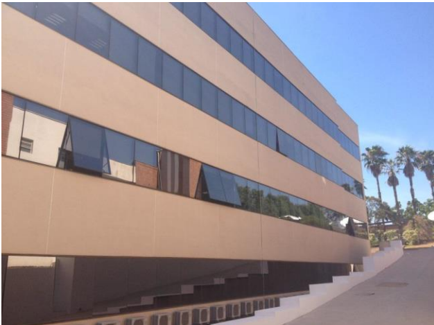
Bloco Administrativo 02 – fachada lateral
