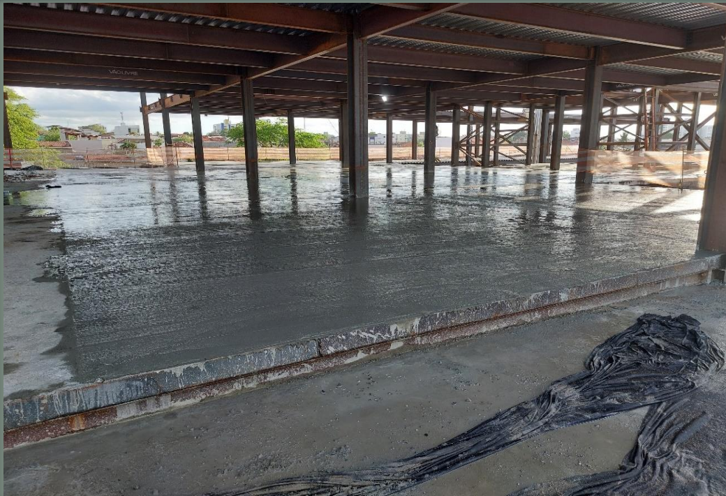
Concretagem das lajes.
