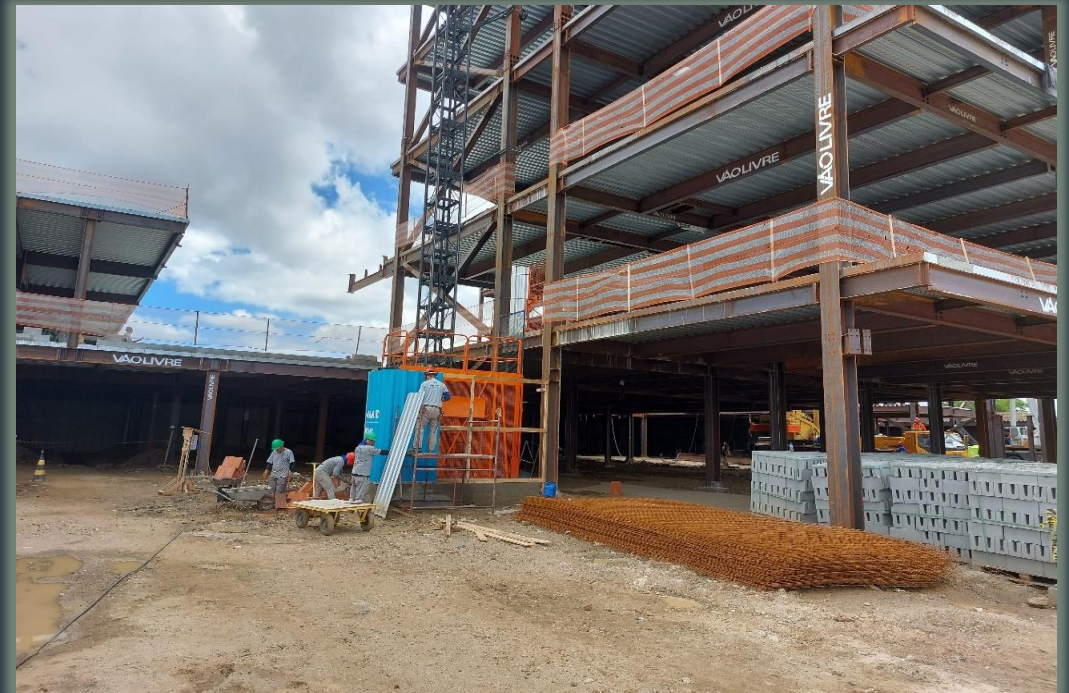
Instalação do elevador cremalheira
