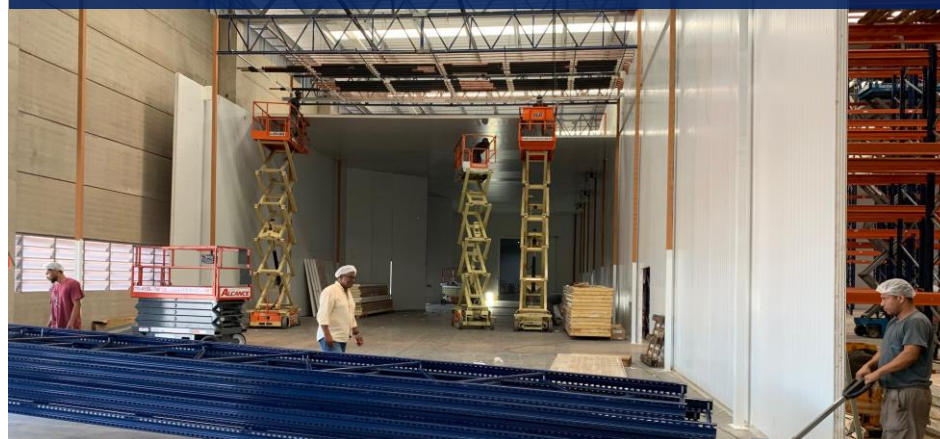
Construção da segunda câmara
