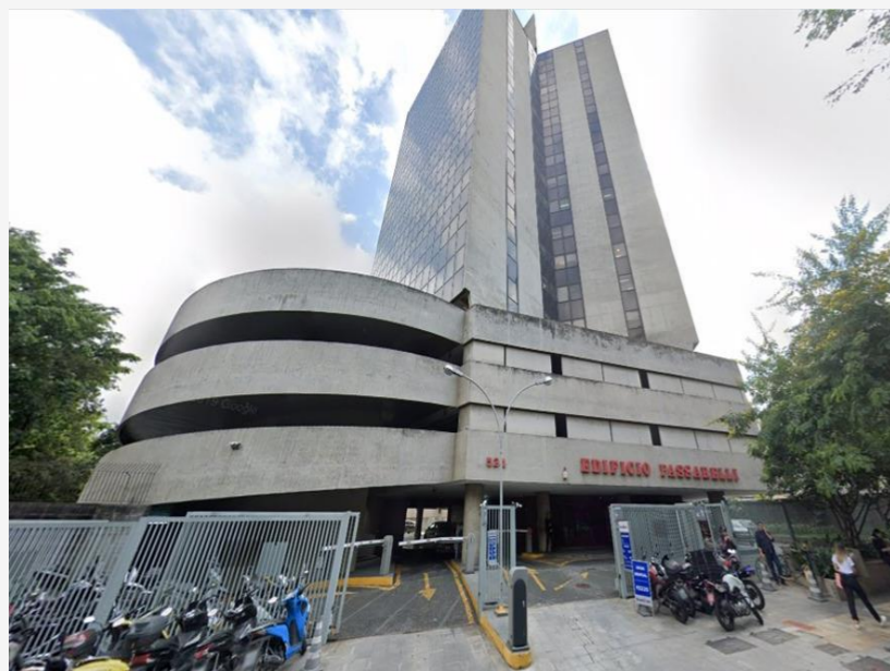
20/05/21 – Antes de iniciar a obra para retirar as grades
