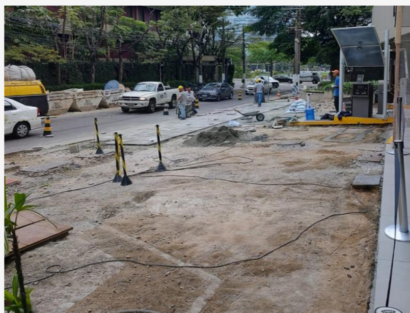
03/10/22 – Durante a obra para retirar as grades
