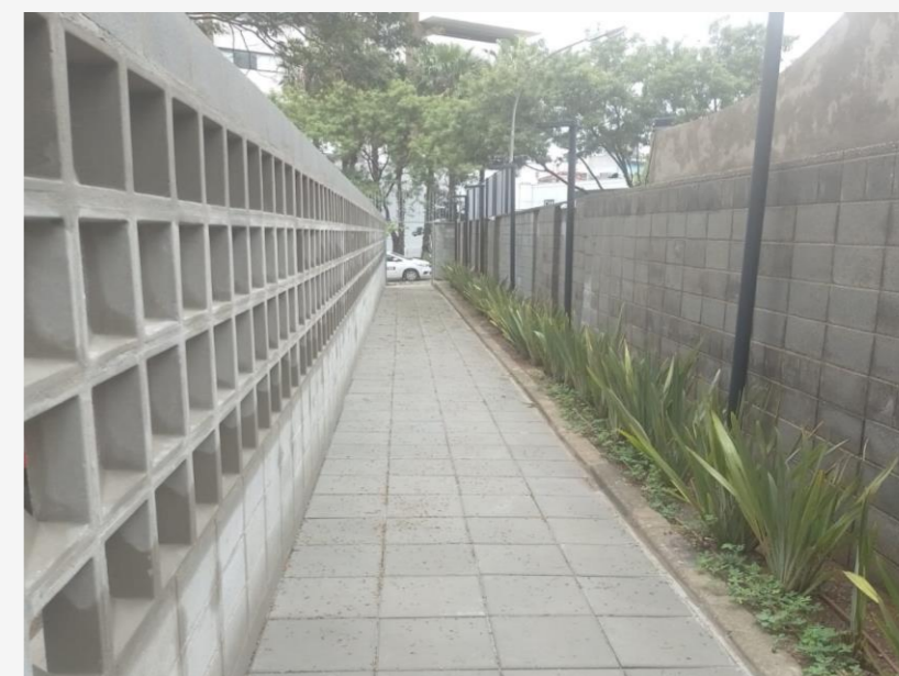
31/10/22 – Acesso finalizado via o edifício para a estação de Pinheiros
