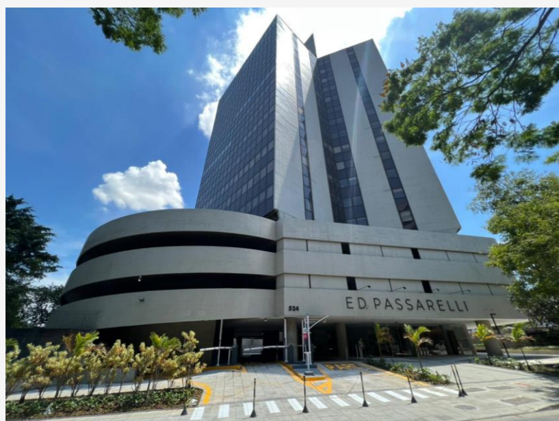
31/10/22 – Após o fim da obra para retirar as grades
